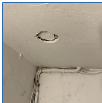
Gaten en opening brandwerend maken
