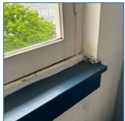
Houtwerk schilderen en lekkage verhelpen
