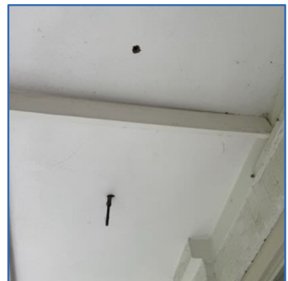
Ijzers verwijderen en gaten dichten
