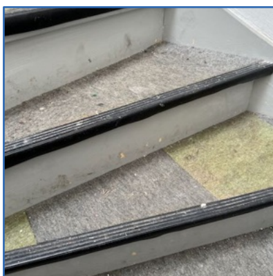
Trapbekleding vervangen
