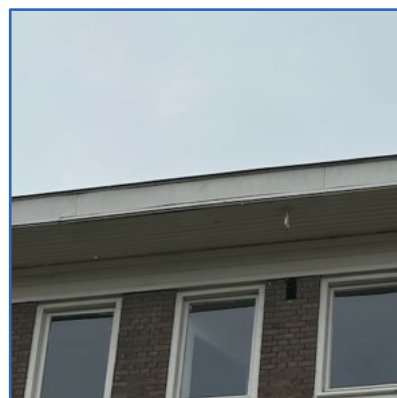
Houtwerk schilderen en hijshaak ontroesten en coating aanbrengen
