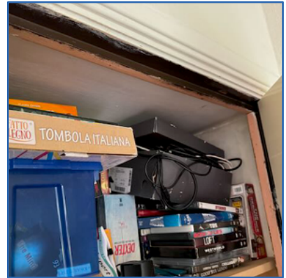
Plafonds inbouwkasten brandwerend maken
