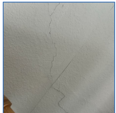
Schuren in plafonds en bouwmuren repareren
