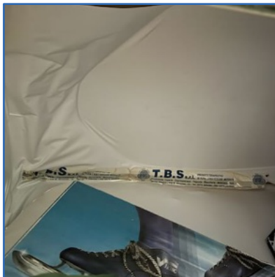
Plafonds inbouwkasten brandwerend maken
