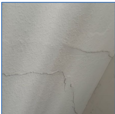
Schuren in plafonds en bouwmuren repareren
