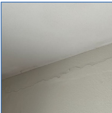
Schuren in plafonds en bouwmuren repareren
