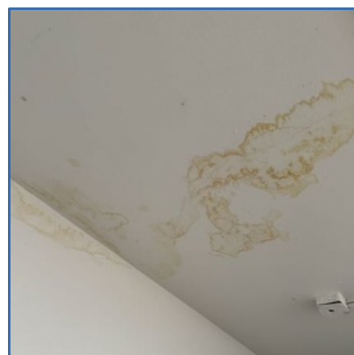
Lekkage verhelpen en muren en plafond herstellen
