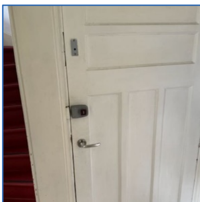
Brandwerende woningtoegangsdeur plaatsen
