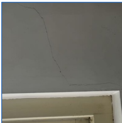
Schuren in plafonds en bouwmuren repareren
