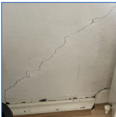
Schuren in plafonds en bouwmuren repareren
