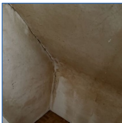
Lekkage verhelpen en muren en plafond herstellen en scheuren dichtmaken (brandwerend)
