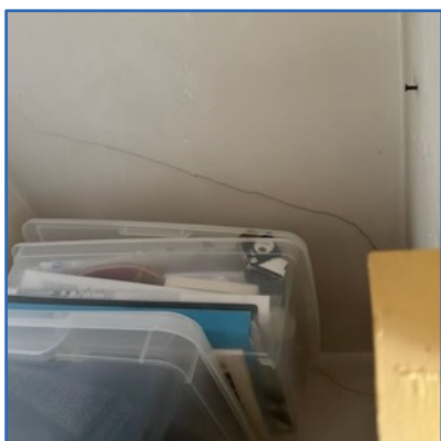
Plafonds inbouwkasten brandwerend maken
